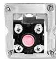
Zdj. Zabezpieczenie za wysokiej temperatury zasobnika
