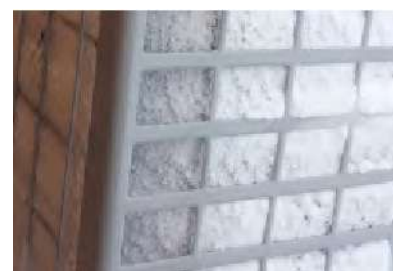
Parownik pokryty lodem
